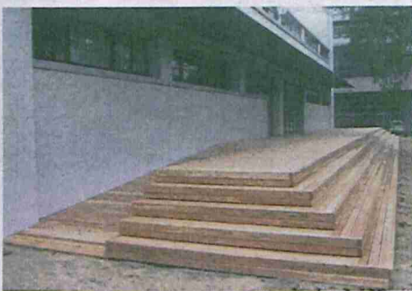
上/レストランの屋外デッキでの施工例。池に浮かぶようなデザインのため、耐水性と池の魚への安全性が認められました。右/屋外エントランスデッキの施工例。十分な強度があるので、人の出入りが多い場所にも設置可能。車いす用のスロープも付いています
